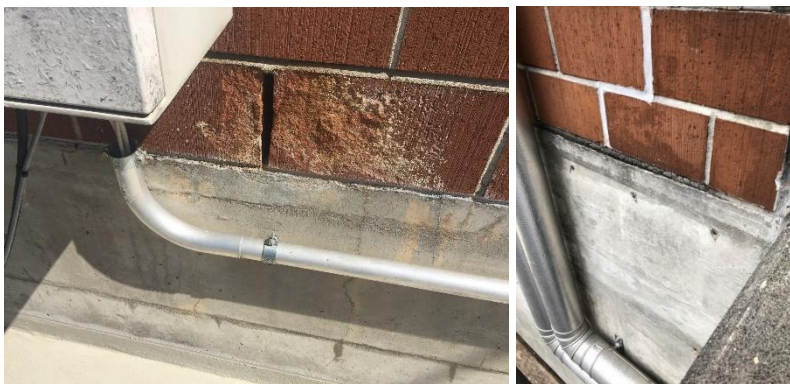
Abbildung 14: vorgehängte Fassade (r.), Fuge (l.)
