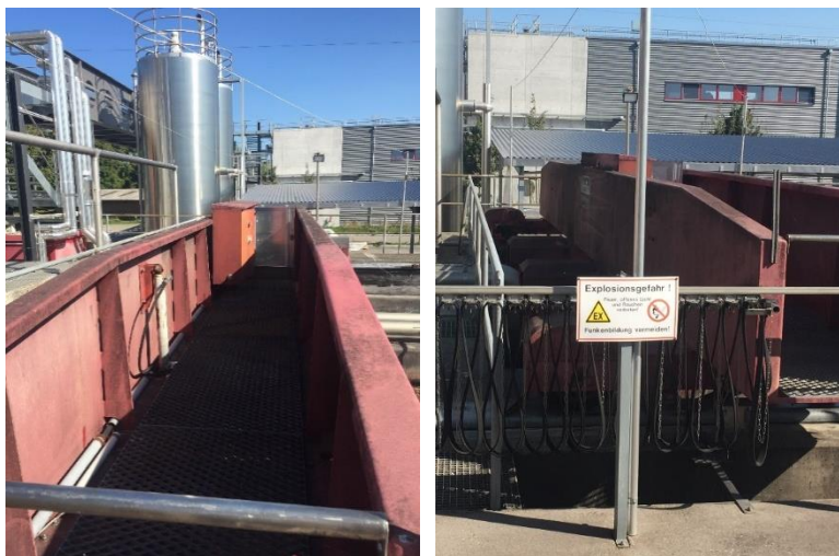
Abbildung 20: Sandfang-Räumerbücke mit Schalt- und Steuerschrank (l.), Schleppkabel Stromversorgung (r.)
