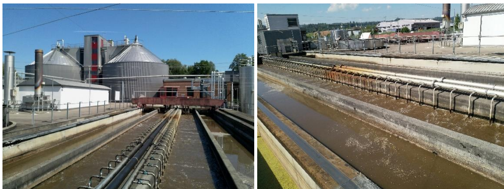
Abbildung 16: Ansicht Sand- und Fettfang mit Zwillingsräumer und Lufteintragssystem
