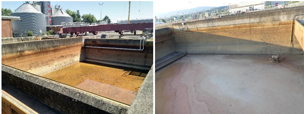
Abbildung 23: Faulwasserstapel (l.), Faulwasserstapel mit Tauchmotorrührwerk (r.)
