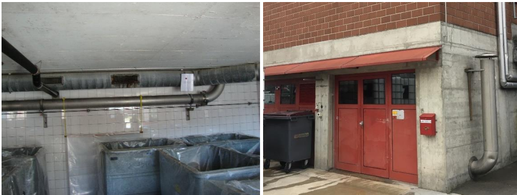
Abbildung 28: Abluftfassung Muldenhalle (l.), Aussenluftnachströmungsöffnungen (r.)
