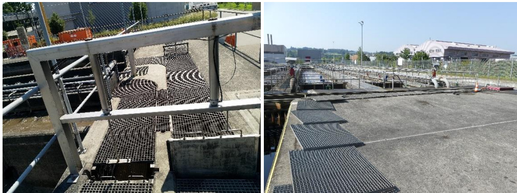
Abbildung 24: Schützen Ablauf Sandfang (l.), Schützen Ablauf VKB (r.)
