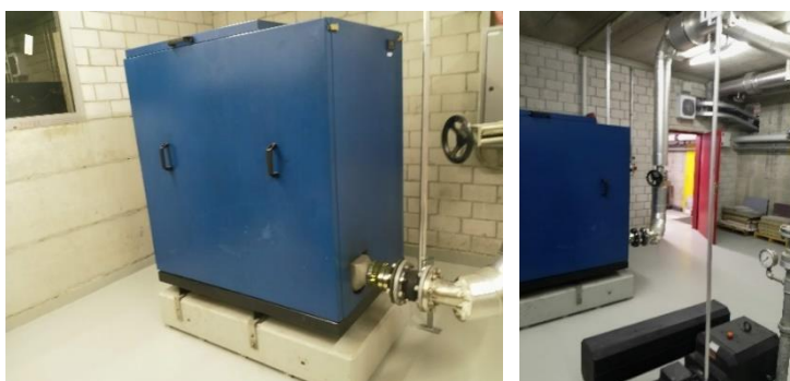
Abbildung 18: Gebläse Sandfang (l.), Gebläse Mammutpumpe (r.)
