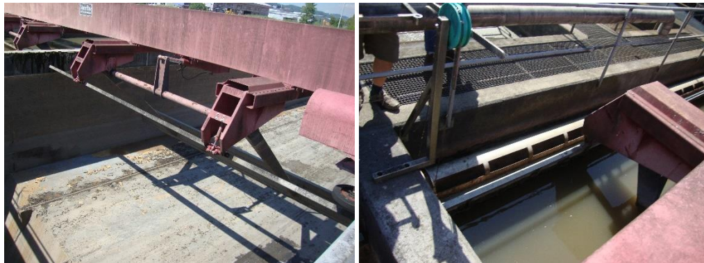
Abbildung 22: Räumerschilde Zwillingräumer (l.), Schwimmschlammabzug (r.)
