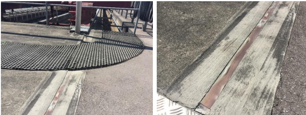
Abbildung 26: Asphaltbelag, Aussinterungen im Belag und Dilatation (l.), Blasenbildung und aufgebrochener Einbettungsmörtel (r.)
