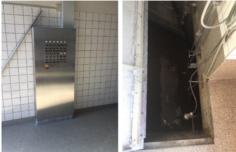
Abbildung 15: Schaltschrank Rechen mit Sicherheitsschalter (l.), Teilansicht Prozessmesstechnik (r.)
