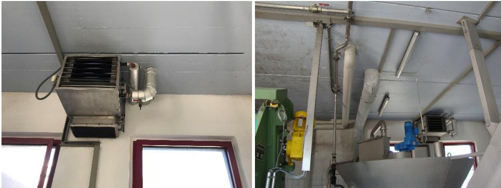
Abbildung 27: Luftheizapparat Rechengebäude (l.), Abluftkanäle (r.)
