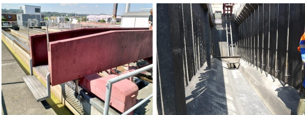
Abbildung 17: Zwillingsräumer (l.), innerhalb des Sandfangs (r.)
